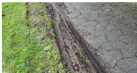
Eksempel på en snerydningsskade.
